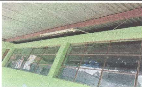
Foto 3: Sustitución de Vidrios modulo de aulas
