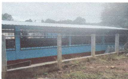
Foto 6: Fabricación e Intalación de ventana-balcón de metal modulo de aulas
