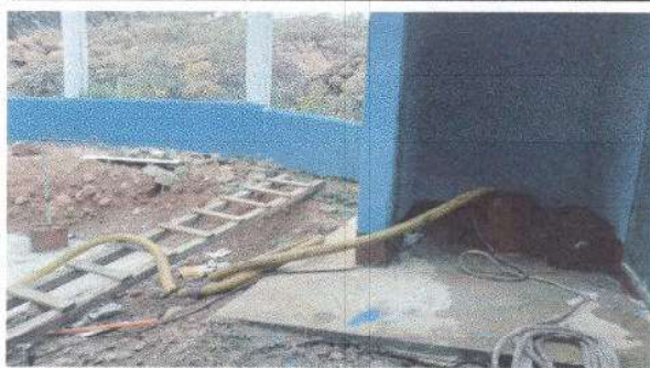
Foto 5: Limpieza de fosa séptica, extracción de aguas negras modulo de baños
