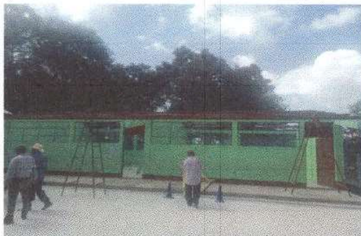
Foto 1: Sustitución de lámina por lámina troquelada MAXALUM calibre 26 modulo de aulas
