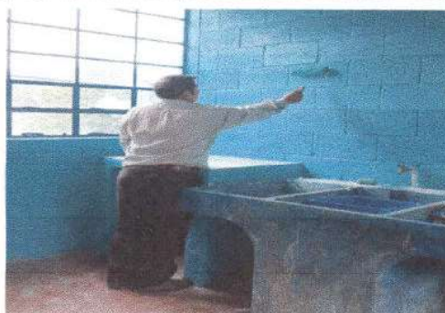
Foto 4: Pintura en muros interiores (Cocina)
