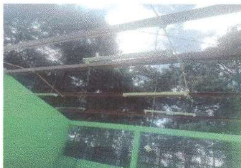
Foto 2: Reparación de Cableado Electrico modulo de aulas
